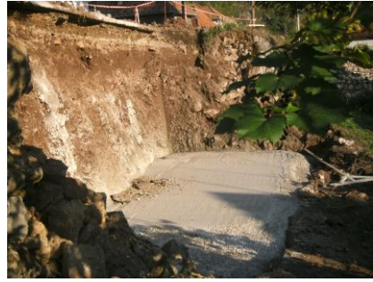
Fig. 21. Lucrările executate de autorități pentru consolidarea străzii (Popa Anca, 2015)
