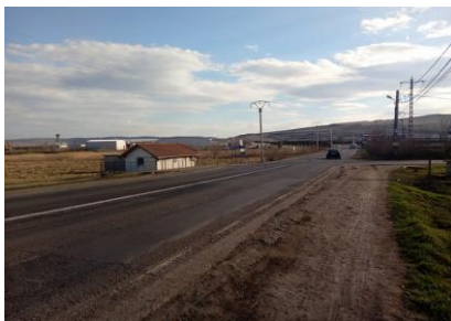
Fig. 9. Intersecția dintre DN1 (E81) și drumul spre Oiejdea (Popa Anca, 2018)
