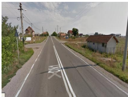
Fig. 7. Intersecția DN1 (E81) cu drumul de acces spre Oiejdea (Google Maps, Popa Anca, 2016)
