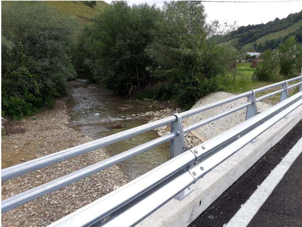
Fig.7 Podul construit după inundații la confluența râului Ilișua cu pârâul Strâmba în localitatea Târlișua (foto: Béla Kobulniczky, 5 August 2019)
