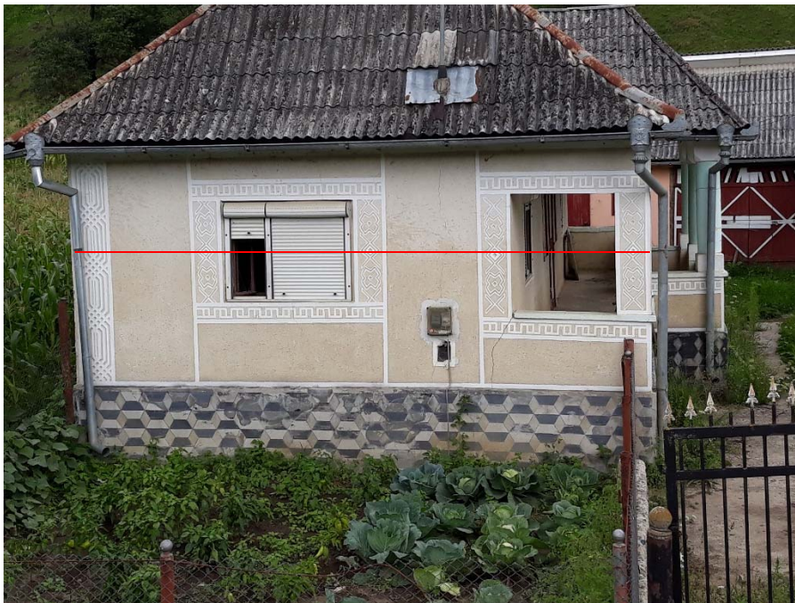
Fig. 6 Nivelul apei observat pe o casă pe malul stâng al râului Ilișua la confluență cu pârâul Strâmba în localitatea Târlișua (foto: Béla Kobulniczky, 5 August 2019)
