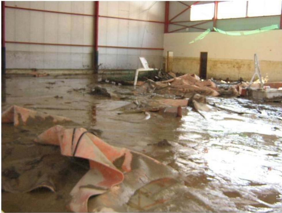
Fig. 4 Sala de sport afectată din Târlisua
