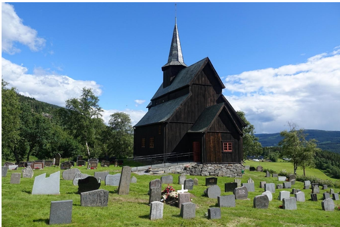
Ill. 2. Stavkyrkja i Høre, Vang i Valdres, bygd i 1180 eller kort etter. Kyrkja har hatt svalgangar, men desse vart fjerna under ei større ombygging i 1822. Då vart også det gamle spontaket skift ut med takstein.
