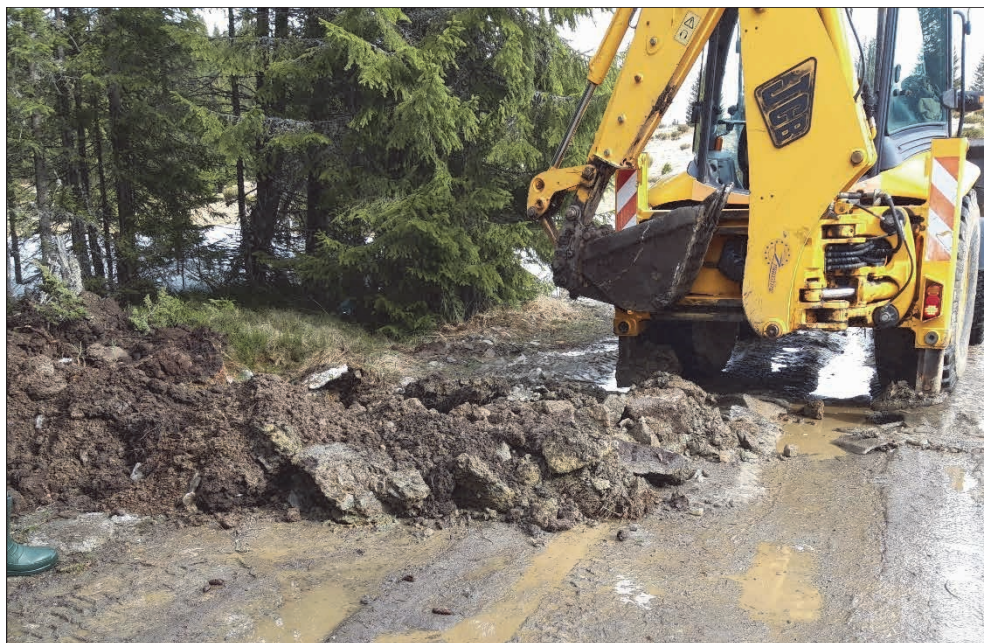
Utilaj folosit pentru montarea tubului de drenaj la Tinovul La Poduri
