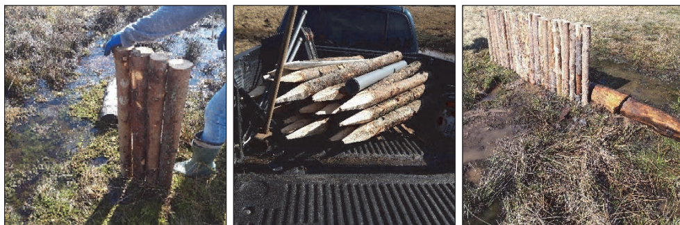
Etape de construcție a stăvilărilor de la Tinovul Bălileasa
