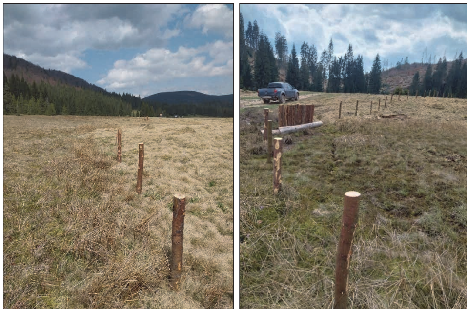
Etape de realizare a împrejmuirii de la Tinovul Băileasa
