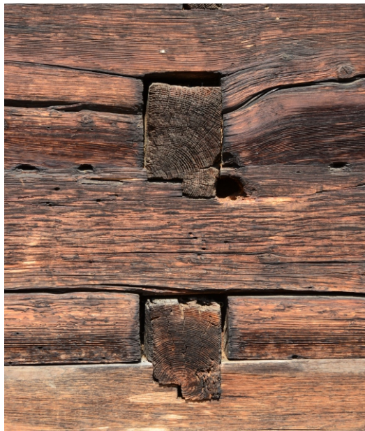
Îmbinarea la colțuri este în „cheotoare în dinte”
