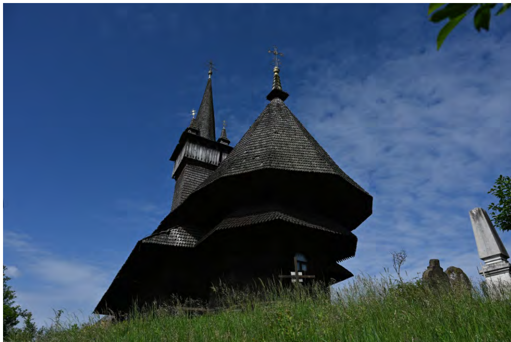
Arșu de Jos (Нижня Апша, Nijnea Arșu, Nyzhnya Arsha) Biserica de lemn „ Sfântul Nicolae ” Biserică Greco-Catolică Română Anul edificării: 1659 Monument istoric Biserică construită în stil maramureșean
