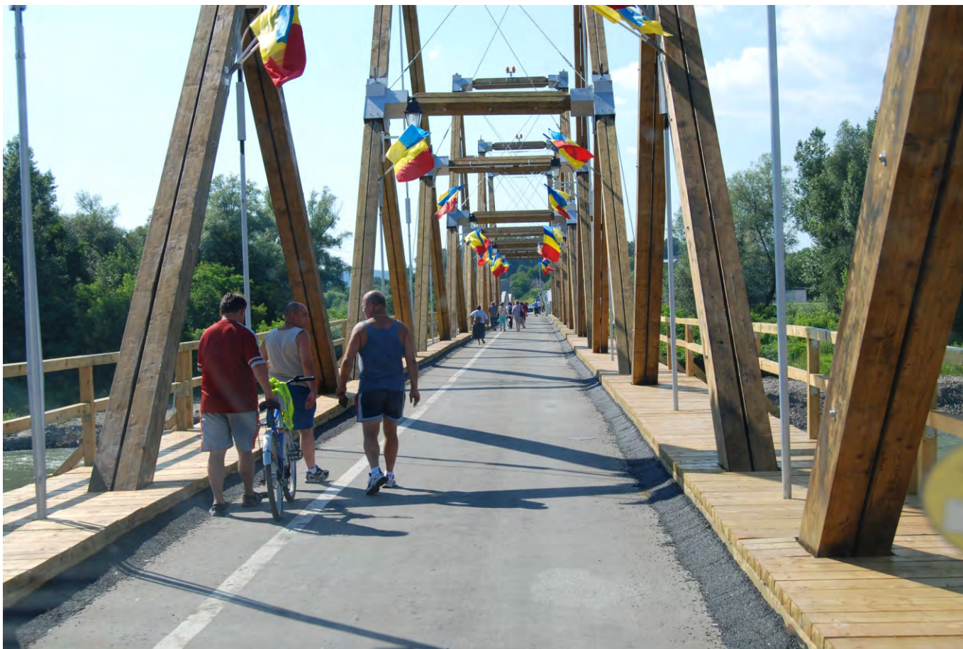
Podul istoric de peste Râul Tisa Punctul de trecere a frontierei de stat Sighetu Marmăției - Solotvino (Slatina) Anul reconstruirii: 2000
