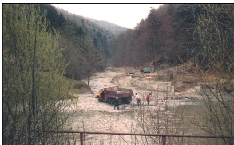
Fig. 61. Materialele acumulate în conul aluvial al Văii Rele sunt îndepărtate (eliminate) pentru a nu colmata lacul hidroenergetic din aval, situat în vecinătatea gării Sinaia
